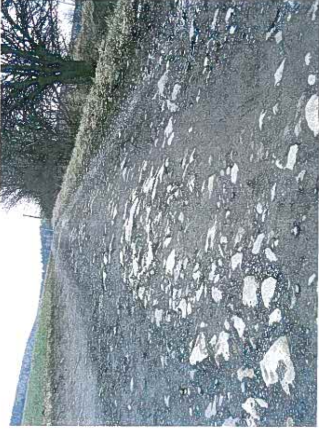
Pohled na zbytky štětového krytu původní cesty - cca km 0,600 úseku A
