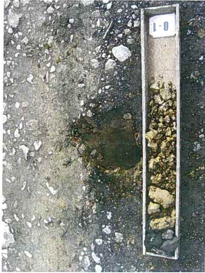
Pohled na zbytky štětového krytu původní cesty - cca km 0,600 úseku A
